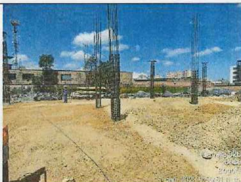
EXCAVACION MANUAL ZAPATAS BLOQUE 7 - 02/09/2023
