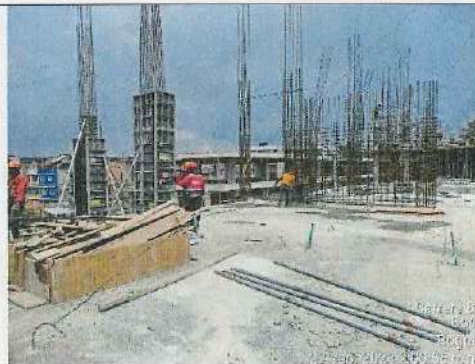
ARMADO DE ACERO COLUMNAS NIVEL + 8,00 BLOQUE 1 - 28/09/2023
