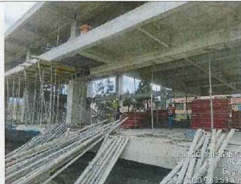
ARMADO ESTRUCTURA EN STEN PARA PLACA NIVEL 4,20 BLOQUE 2 - 05/09/2023
