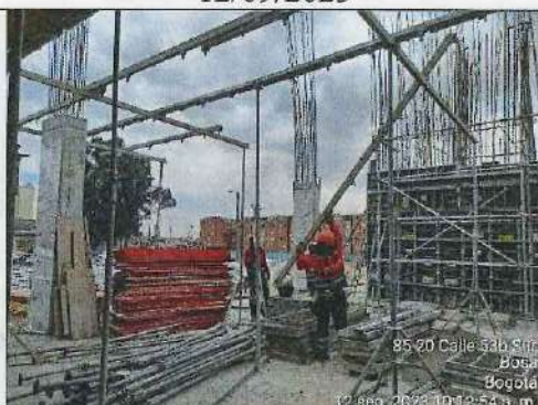
ARMADO DE ACERO VIGAS PARA PLACA NIVEL + 8,00 BLOQUE 1 - 12/09/2023
