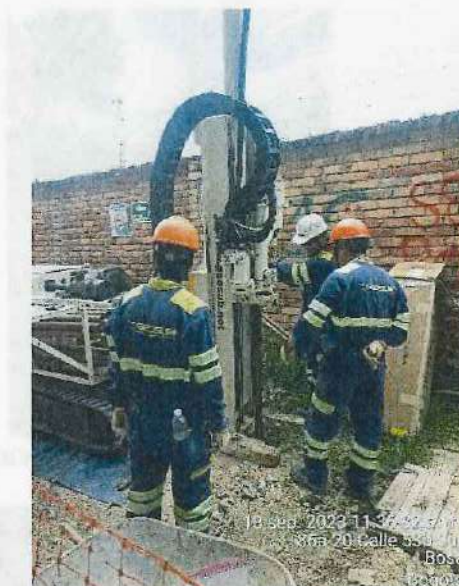
Perforación para toma de muestras. Fecha: 18-09-2023.
