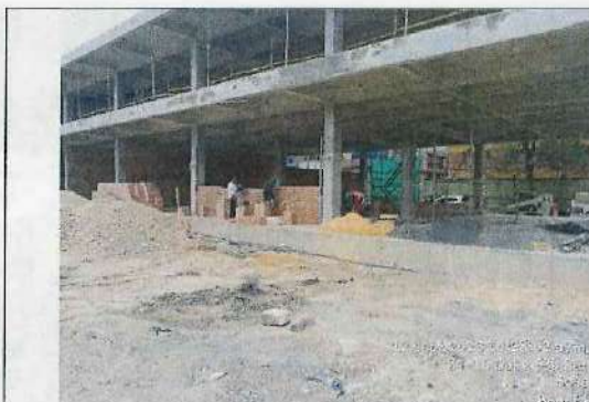
ARMADO DE PLATAFORMA PARA PLACA NIVEL + 4,20 BLOQUE 2 - 12/09/2023
